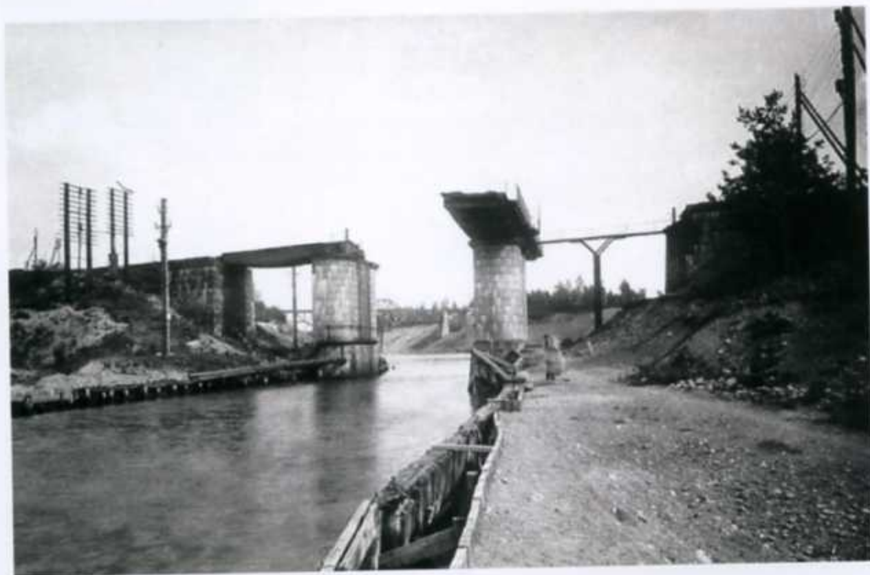
Den gamla järnvägsbron står öppen och väntar på att rivas. Vi ser den nygamla järnvägsbron i bakgrunden.
